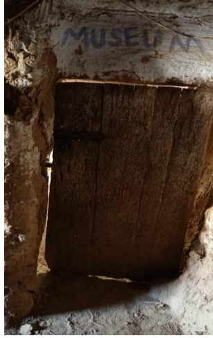
شكل ١٤ ، لشكل الأبواب في درب السندادية بواحة الخارجة المصنوعة شرايح خشب أشجار الدوم و متراصة بسطح مستوى ( الباحث ) .
